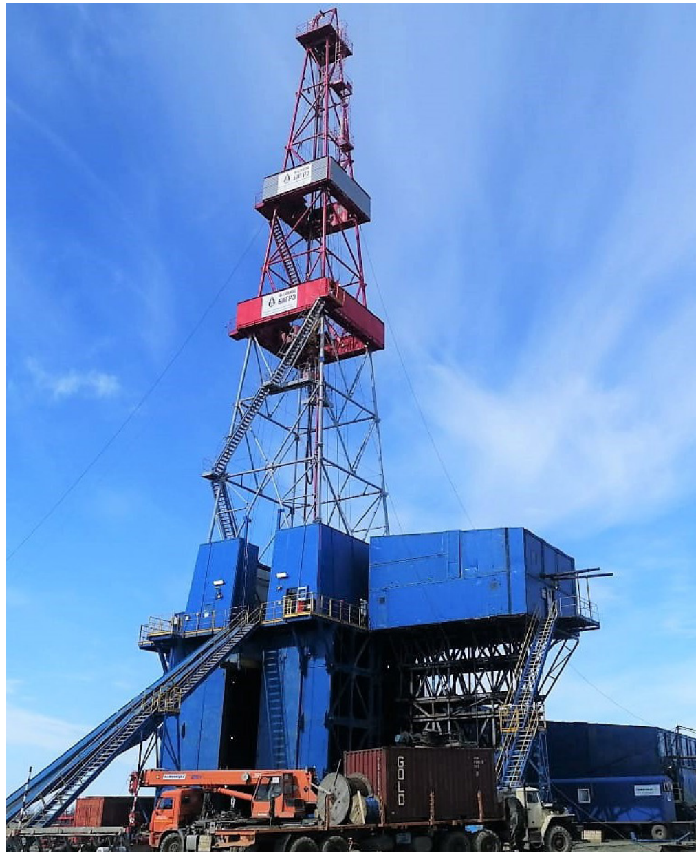
Буровая установка на Лодочной-16
